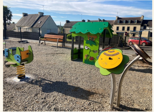
Aire de jeux en cours de travaux
