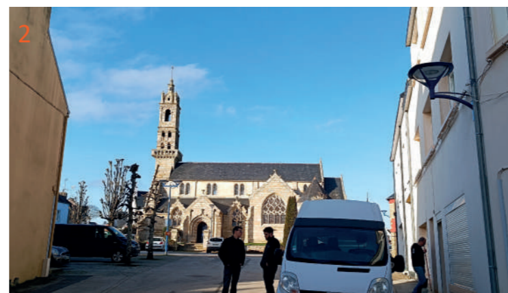
2 Vue de l'Église St-Edern depuis la rue du Puits. Omniprésence de la voiture. Espace minéral. Peu/pas de valorisation du monument.
