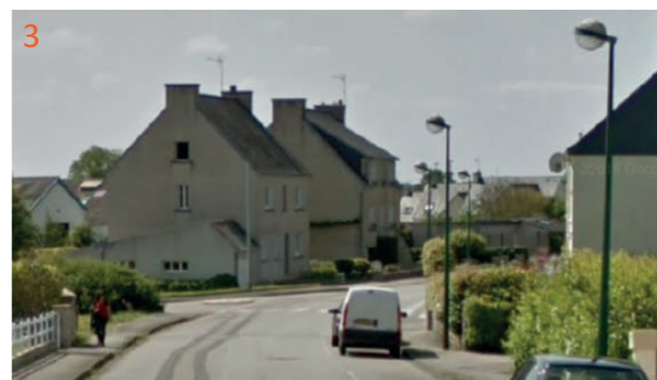
Rue de Lannien, large voirie : 7,20m. Axe permettant de se rendre dans une zone de lotissement. Etat de la chaussée correcte.
