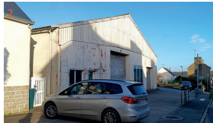
Site de projet, ancien garage, rue des écoles
