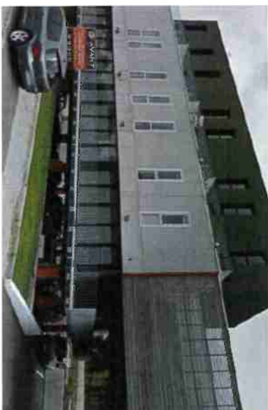
Logement Collectif et bureau – Auray (56) Profitant de la pente, le stationnement se fait de manière semi enterrée tout en étant ouvert.
