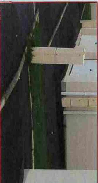
Coffrets isolés risquant d'être percutés par un véhicule
